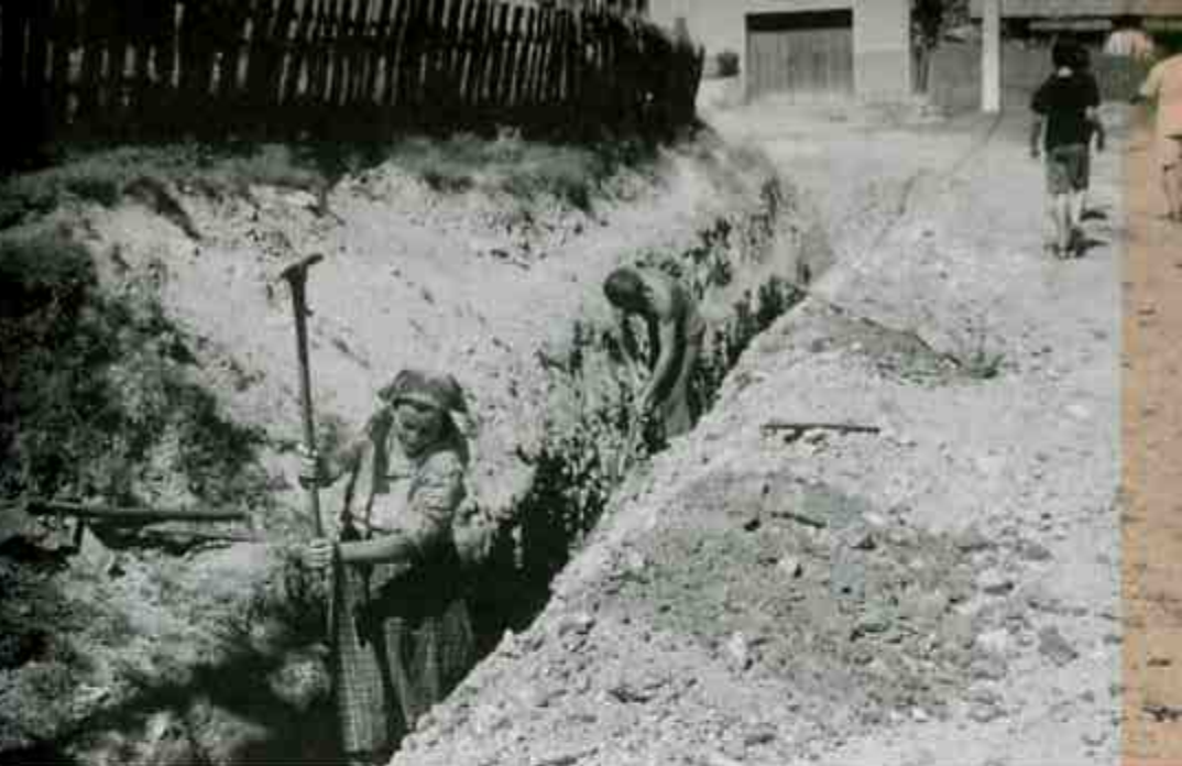
Při kopání vodovodu pomáhali vřiční. Sešla se celá vesnice.
