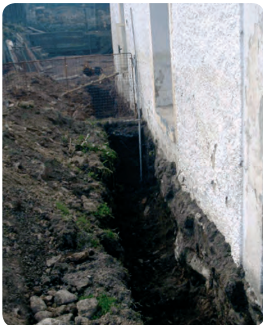
Při provádění drenáže je potřeba postupovat maximálně opatrně, hrozí porušení stability objektu zdroj: Člověk v tísni
